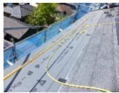
既存屋根材の上に 防水シートを敷く
