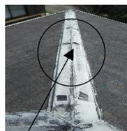
棟破損箇所（応急処置済）
